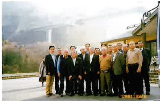
建設中の2号橋(高さ87m)
